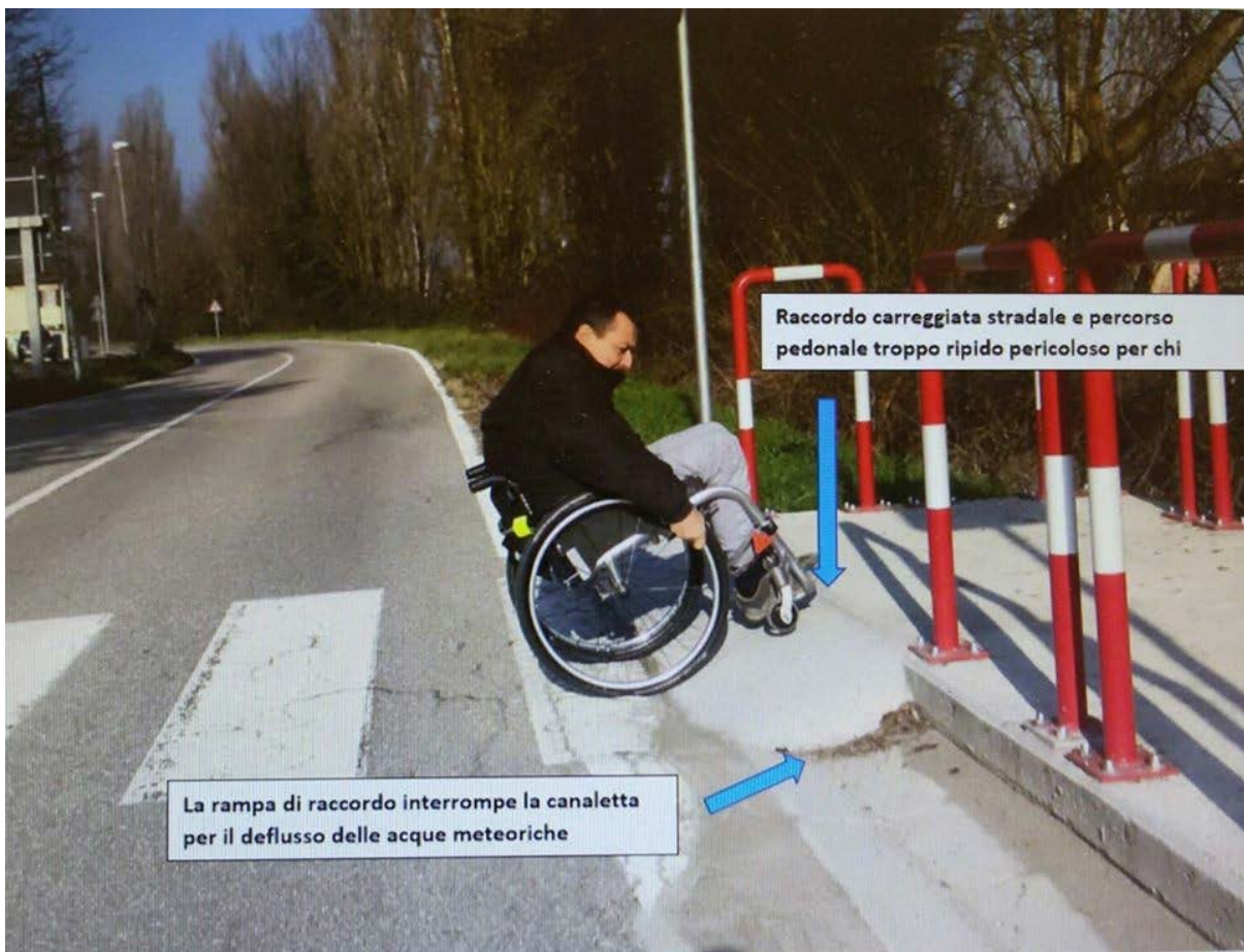
Rampa di accesso al percorso ciclopedonale dalla SP65
